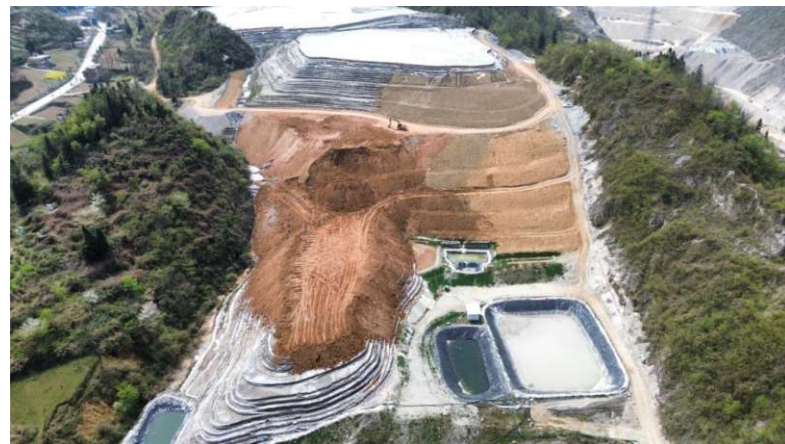
大坡槽露天地质环境恢复治理工程
